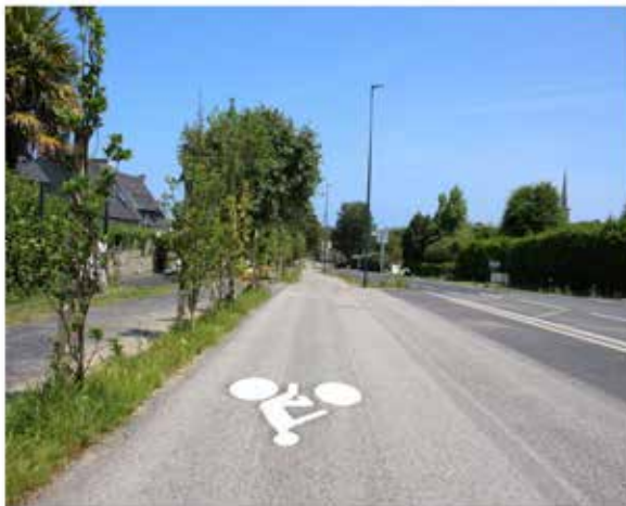
Sur l'avenue Le Bras, à Paimpol (Côtes-d'Armor), il y a désormais trois voies distinctes pour les piétons, les vélos et les voitures. ©Arnick GUILLEMET
